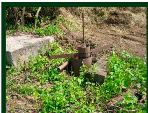
POZO PROFUNDO DE 50 METROS DE PROFUNDIDAD Y 18" DE ADEME CON UN GASTO DE 35 LPS. SEGÚN AFORO
